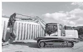
導入した重機
