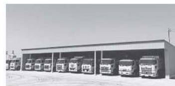
新設した車庫
