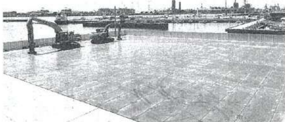
敷鉄板を設置した港町ヤードと竣工した車庫
